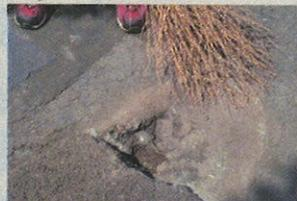
付着を良くするため、施工する箇所の水、泥、ゴミなどを十分に取り除いてください。
