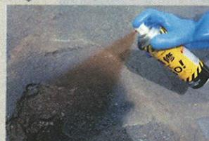
噴射口を施工面に向け、20~30cm離してスプレーしてください。本製品は逆さ吹きが可能です。
