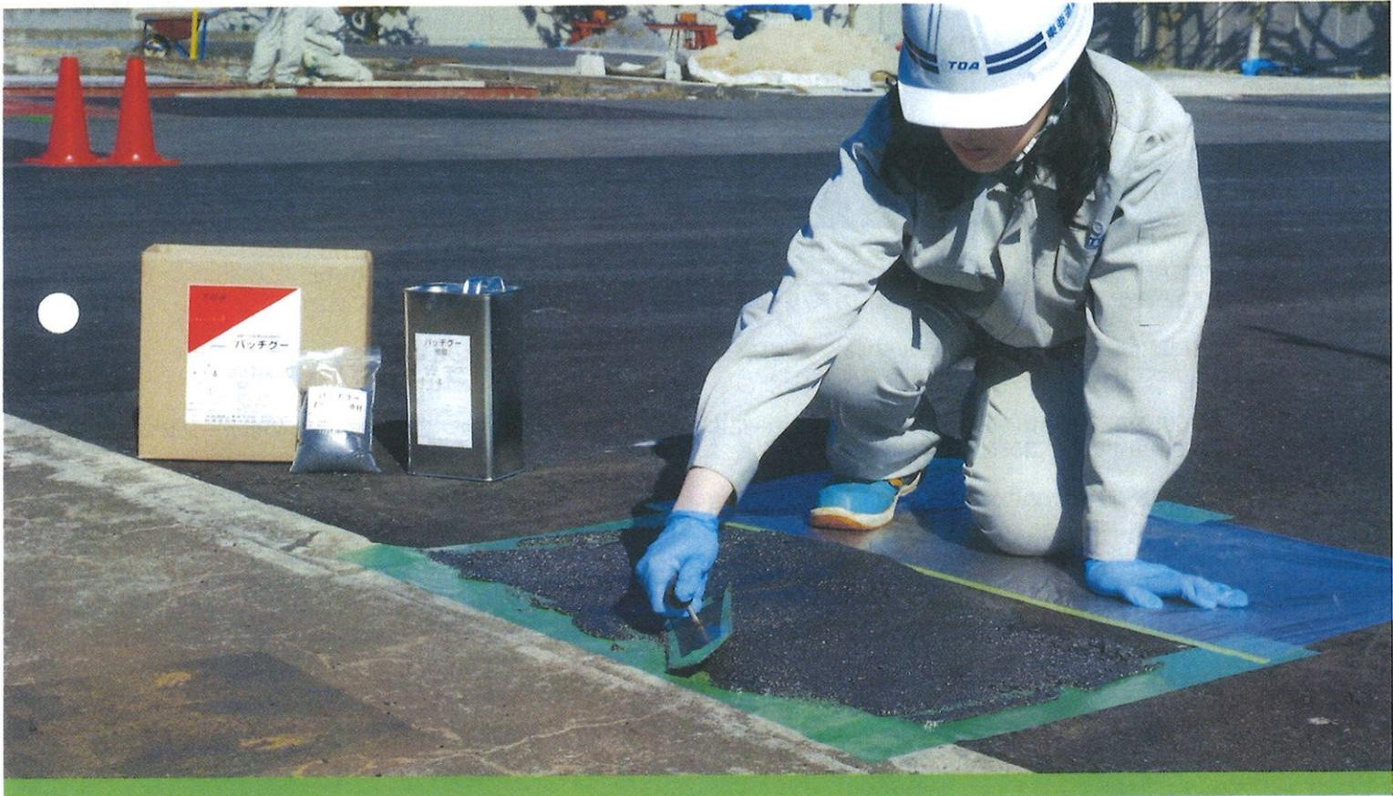
**概要** パッチグーは、橋梁ジョイント部やマンホールなど舗装面に生じた段差の修正、そしてポットホールの穴埋めなど、路面に生じた様々な破損を補修できる特殊アクリル樹脂系路面補修材です。特殊な機材や工具を必要としません。誰でも簡単確実な施工を可能とし、施工後、短時間で交通開放できます。
