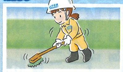
施工箇所を高圧洗浄機またはデッキブラシと水を用いて清掃します。汚れやカビなど取り除いてください。その後、十分に乾燥させてください。
