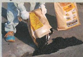
アスファルト混合物を舗設します。(常温混合物コールドバークラス推奨)
