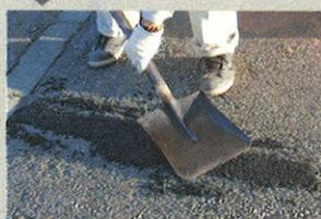
スコップやタンパーを用いて締め固めます。
