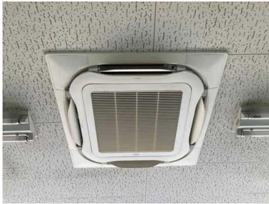
【コンティニューム設置場所】
