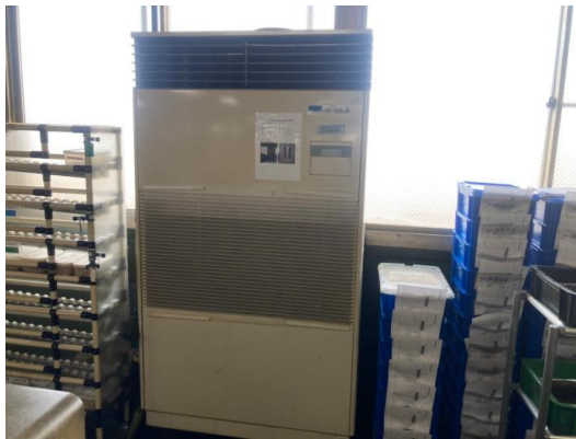
【コンティニューム設置場所】
